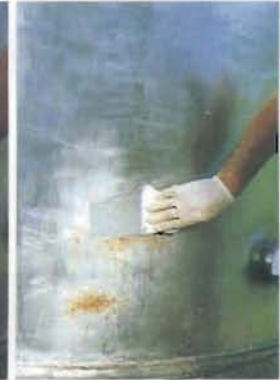
スピードアロイで補修
