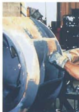
ポンプインペラー セラムアロイ施工中
