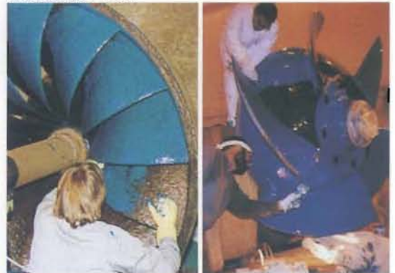
水力発電機ランナー
